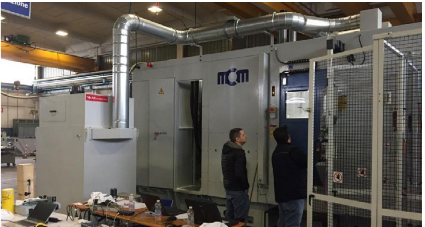
INSTALLATION eines COALFILTER auf einer WZM von MCM
